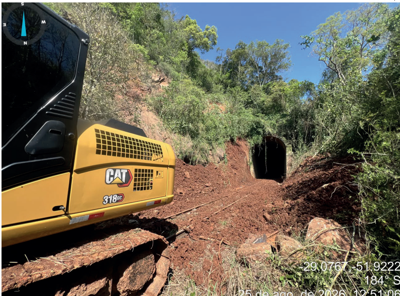
Limpeza dos trilhos e de túneis da Ferrovia do Trigo
