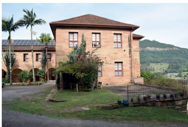
Espaço de hospedagem e refeitório visto de fora
