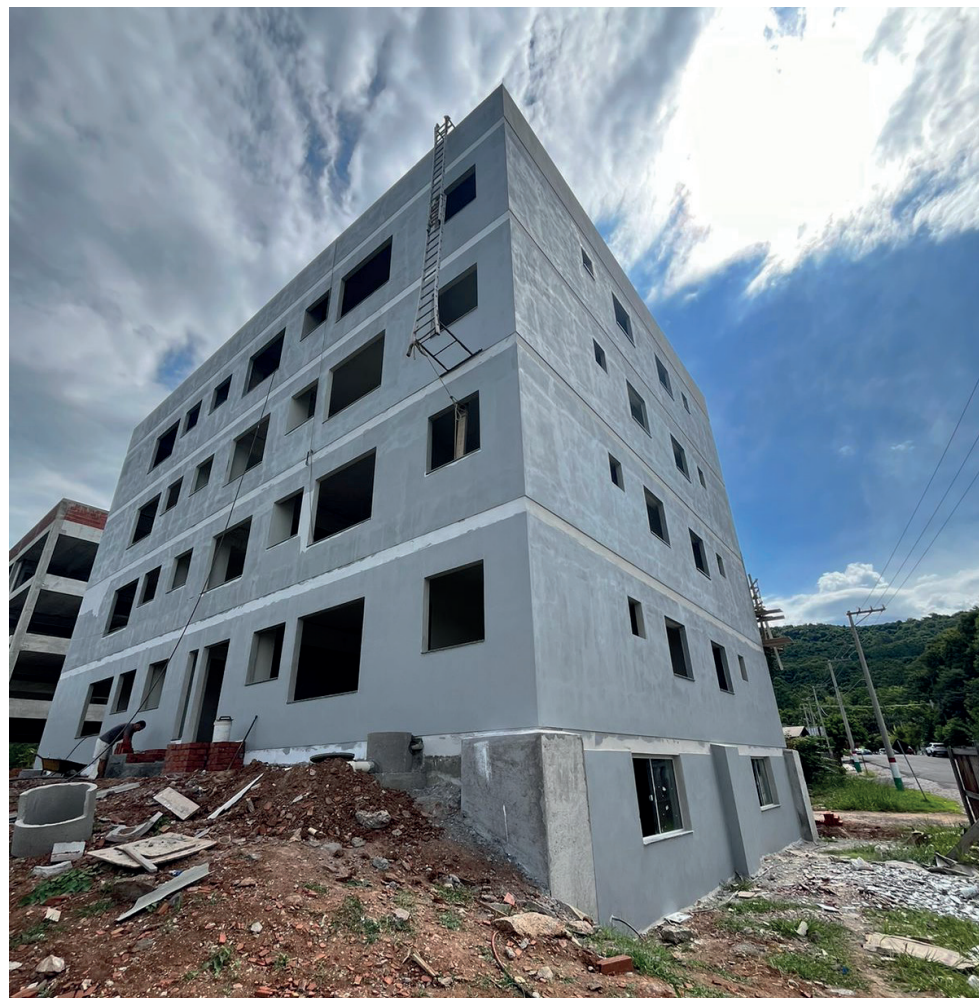
Prédio da SOS Habitar está quase concluído
